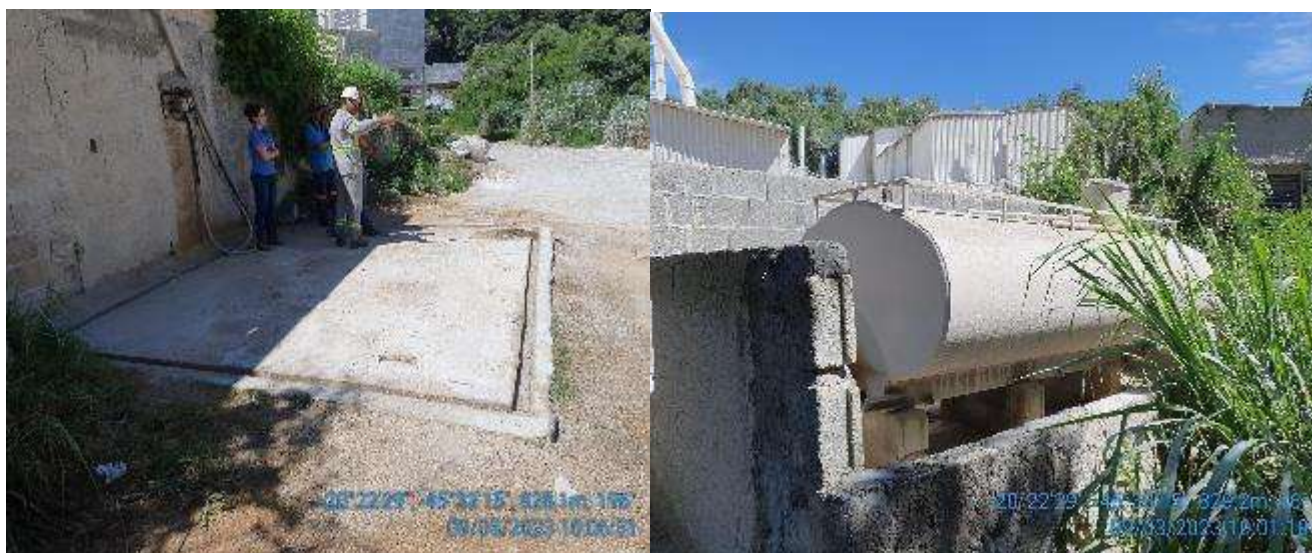
Figura 04: Pista de abastecimento e tanque de combustível. Fonte: Autor.
