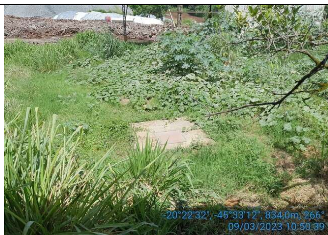
Foto 04. Sistema de tratamento de efluentes sanitários.
