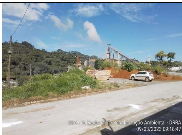
Foto 03. Vista parcial dos fornos e vias internas do empreendimento.
