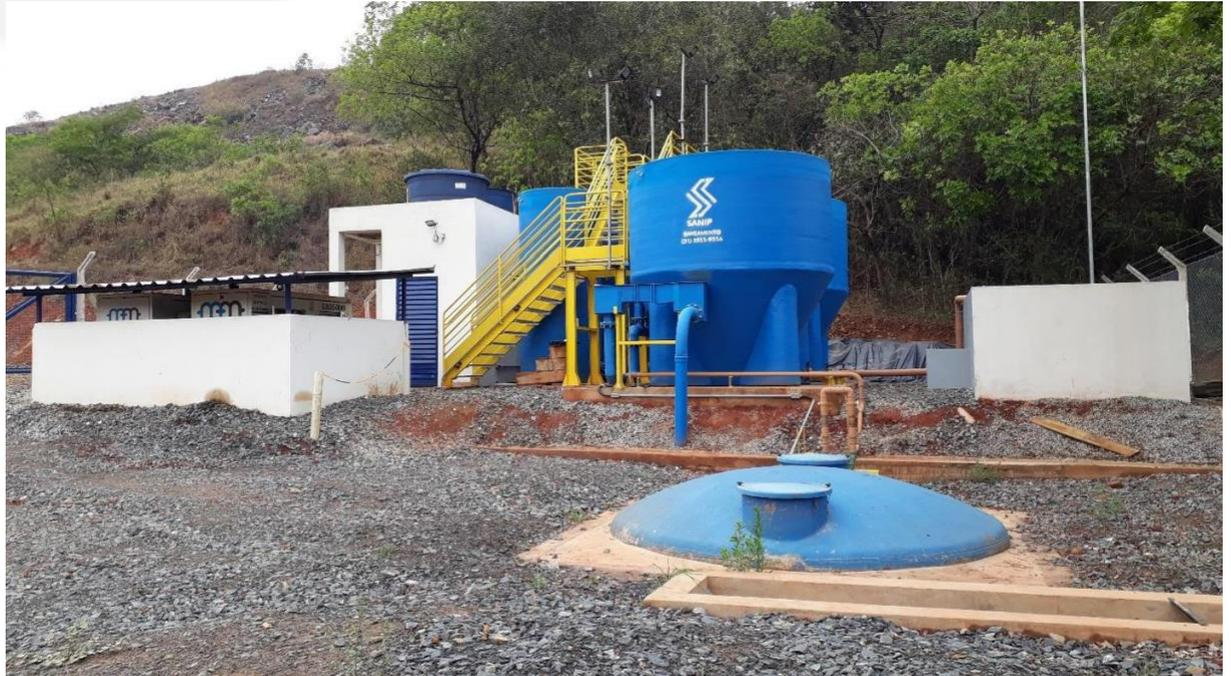
**Figura 11: ETE da pilha de estéril PDE-07.**
