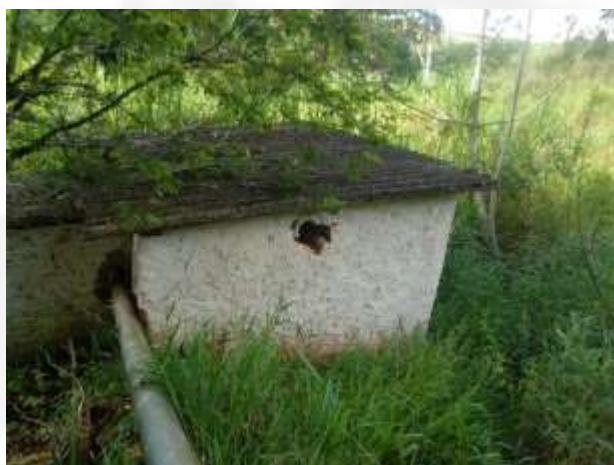
Casa de bomba – captação em um dos barramentos
