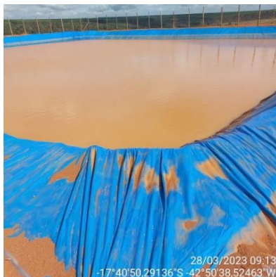
Fotos 13, 14 e 15 – “Piscinões” instalados próximo à silvicultura. Armazenamento de água pluvial para utilização durante os plantios e eventuais incêndios florestais.
