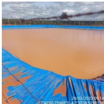
Fotos 13, 14 e 15 – “Piscinões” instalados próximo à silvicultura. Armazenamento de água pluvial para utilização durante os plantios e eventuais incêndios florestais.
