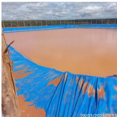
Fotos 13, 14 e 15 – “Piscinões” instalados próximo à silvicultura. Armazenamento de água pluvial para utilização durante os plantios e eventuais incêndios florestais.
