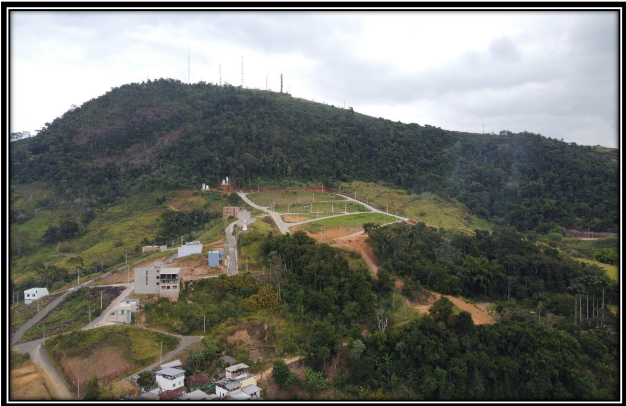
Figura 5: Registro fotográfico do local de uma forma geral.
