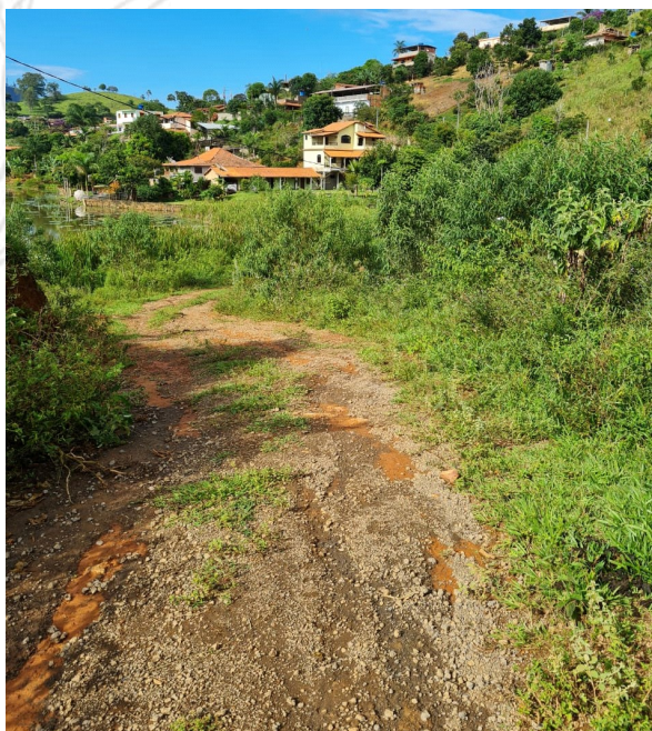
Figura 5: Trecho da via.
