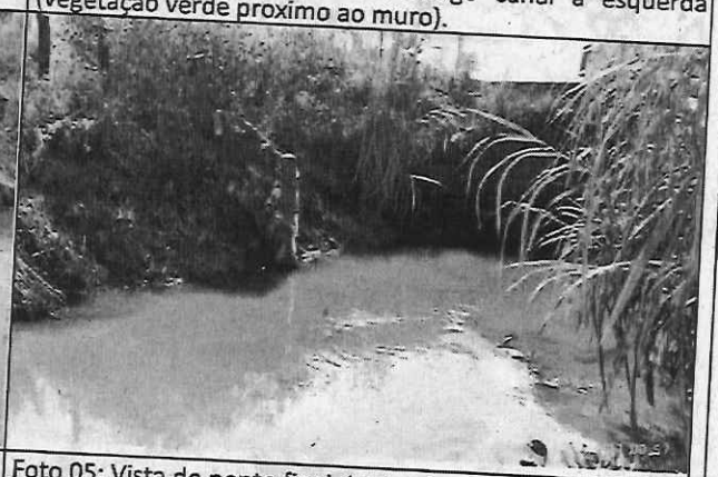
Foto 05: Vista do ponto final do desvio.
