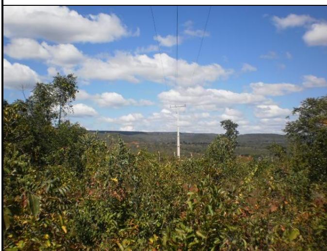
Foto 05: Linha de Transmissão de Energia.
