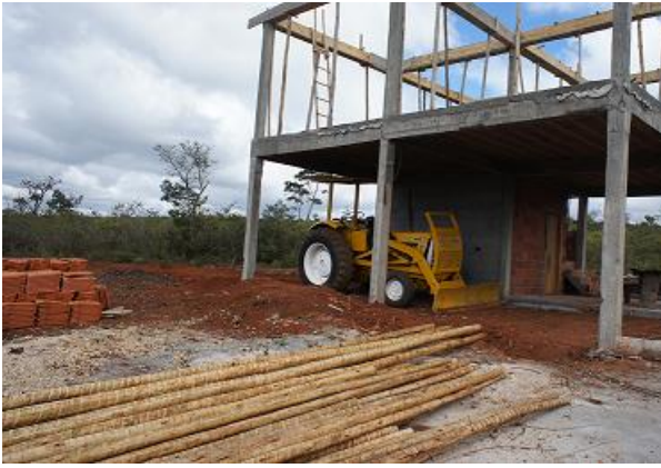
Foto 01 – Obra de infra-estrutura em andamento.
