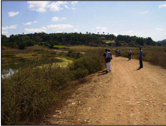
Foto 07. Represamento de água formado a montante do dique.
