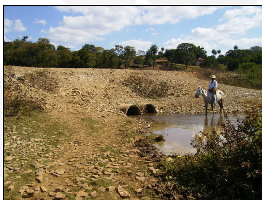
Foto 06. Vista do sistema de drenagem do dique e morador local utilizando a área para passagem.
