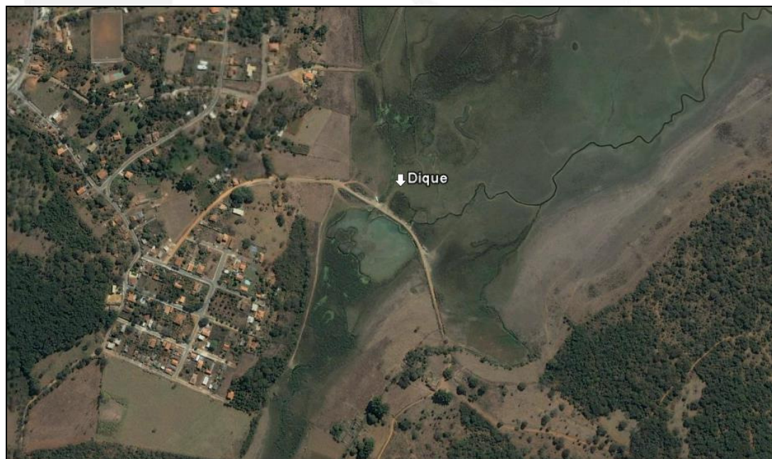
Imagem 02. Detalhe do dique/travessa construído para ligação das margens opostas da Lagoa do Sumidouro.
