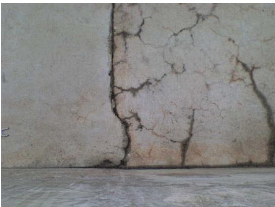
**Foto 07.** Vista interna da bacia de contenção. Observar a presença de rachaduras.
