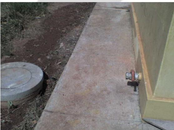
**Foto 09.** Ausência de ligação entre a bacia de contenção e a Caixa SAO .
