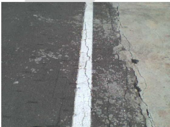
**Foto 03.** Detalhe da pista do aeroporto. Observar rachaduras.
