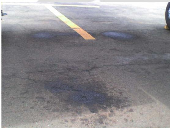
**Foto 04.** Detalhe da pista do aeroporto. Observar manchas oleosas.
