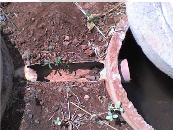
**Foto 11.** Detalhe da Caixa SAO. Observar a presença de cano plástico quebrado.
