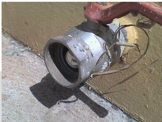
**Foto 08.** Válvula e dreno no lado externo da bacia de contenção. Observar a ausência de ligação com a Caixa SAO.
