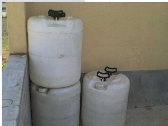
**Foto 06.** Vista interna da bacia de contenção. Observar a presença de bombonas contendo combustível.
