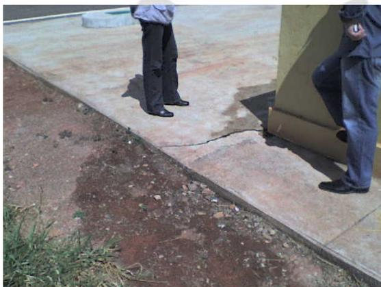
**Foto 10.** Vazamento e rachaduras próximo a bacia de contenção.
