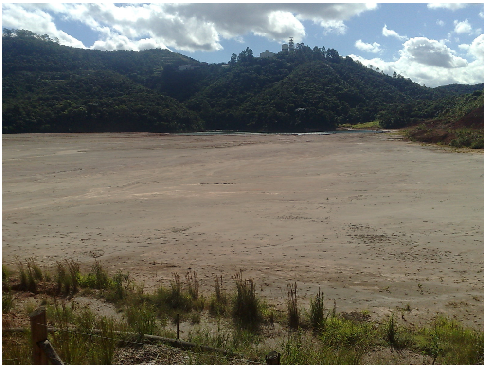
Foto01: barragem de rejeitos da mina
