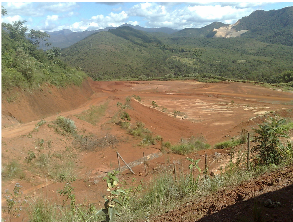
Foto06: área de empréstimo 01 ao lado da barragem
