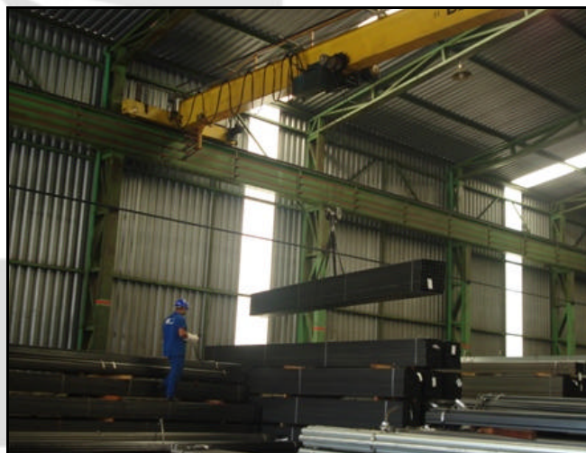
Foto 12. Guindaste para movimentação de material (Unidade 1).
