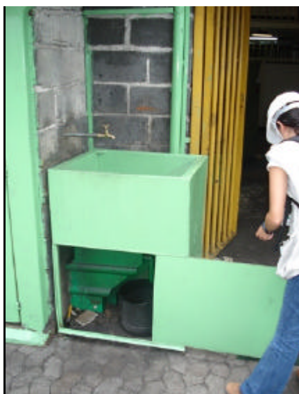
Foto 09. CSAO 01, externa à próxima à Unidade 1, que foi relocada para o interior da Unidade 1.
