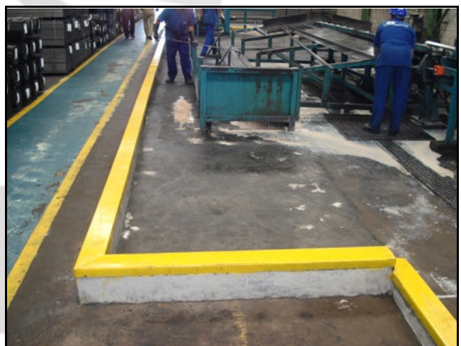
Foto 04. Mureta de proteção e canaletas de drenagem na linha de produção.
