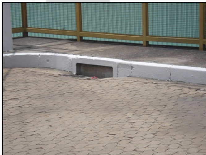
Foto 07. Boca de lobo para drenagem de água pluvial, próxima ao estoque da foto 06.
