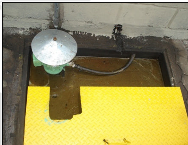
Foto 08. Caixa de passagem com bomba, próxima à Unidade 1, que atendia a ferramentaria, atualmente desativada.
