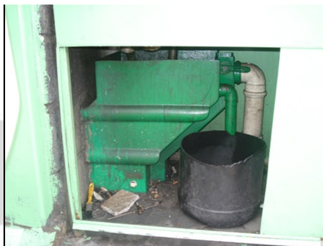
Foto 10. Detalhe da foto 09.
