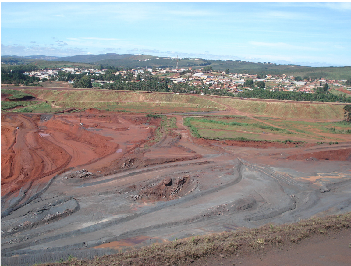
Pilha de estéril Córrego Seco ao fundo, formando barreira física em relação ao bairro Jardim Canadá.
