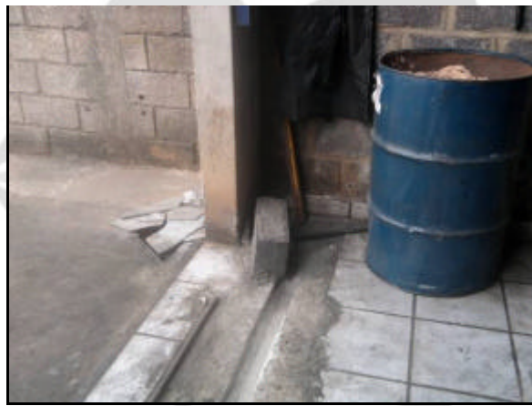
Foto 4: Canaleta de drenagem e caixa de coleta para eventuais derrames de líquidos. Piso com revestimento cerâmico.
