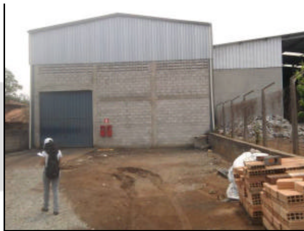
Foto 2: Galpão com acesso coberto por brita e extintores de incêndio.
