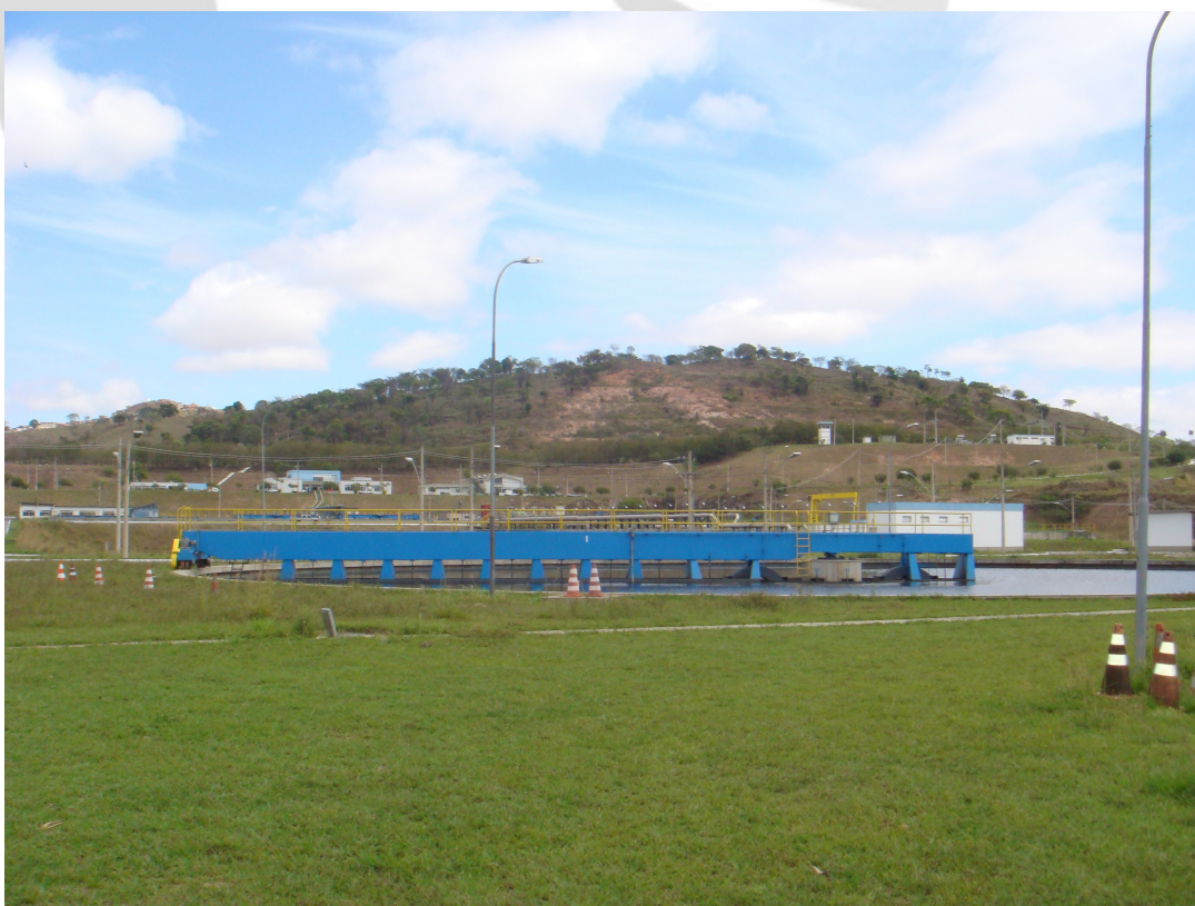
Foto 03: Área de instalação do futuro decantador secundário (em primeiro plano) e decantador secundário em operação (em segundo plano)
