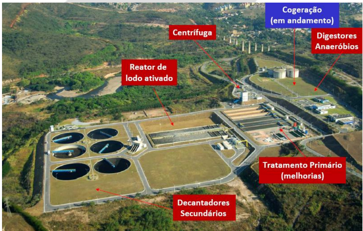
Foto 01: Áreas de ampliação das unidades de tratamento secundário e demais melhorias da ETE Arrudas (fonte: RCA)
