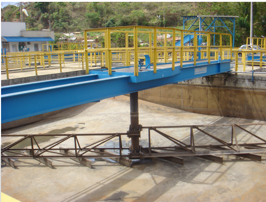
Foto 02: Desarenador do tratamento primário (em manutenção)
