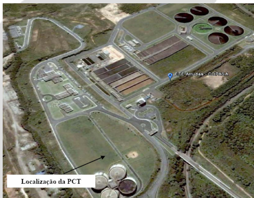
Foto 1: vista aérea da ETE Arrudas e indicação da localização da PCT.
