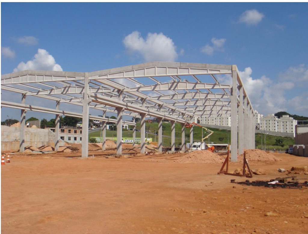
Foto 02: Obras do empreendimento iniciadas. Situação em 12/05/2009.
