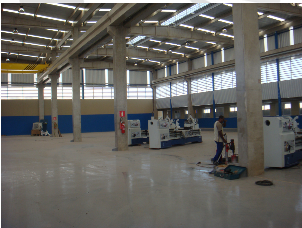
Foto 03: Obras do empreendimento em fase avançada. Situação em 09/02/2010.
