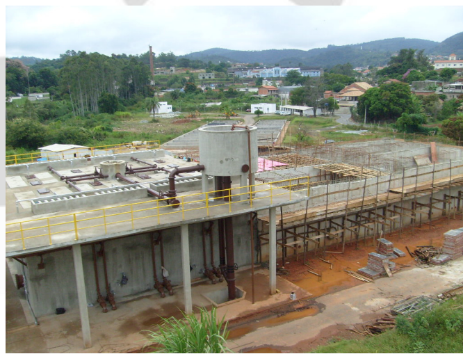
Foto 04: Vista dos 2 reatores UASB implantados e dos 4 restantes em construção.
