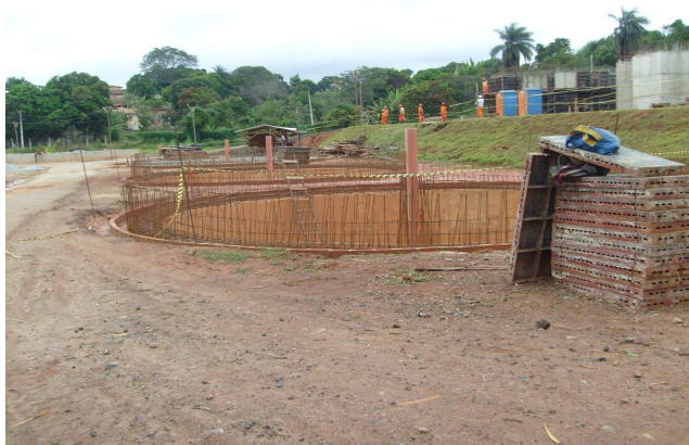
Foto 07: Tratamento secundário: três Decantadores em fase de implantação
