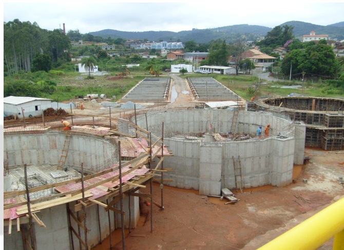
Foto 06: Tratamento secundário: 3 Filtros Biológicos em fase de implantação.
