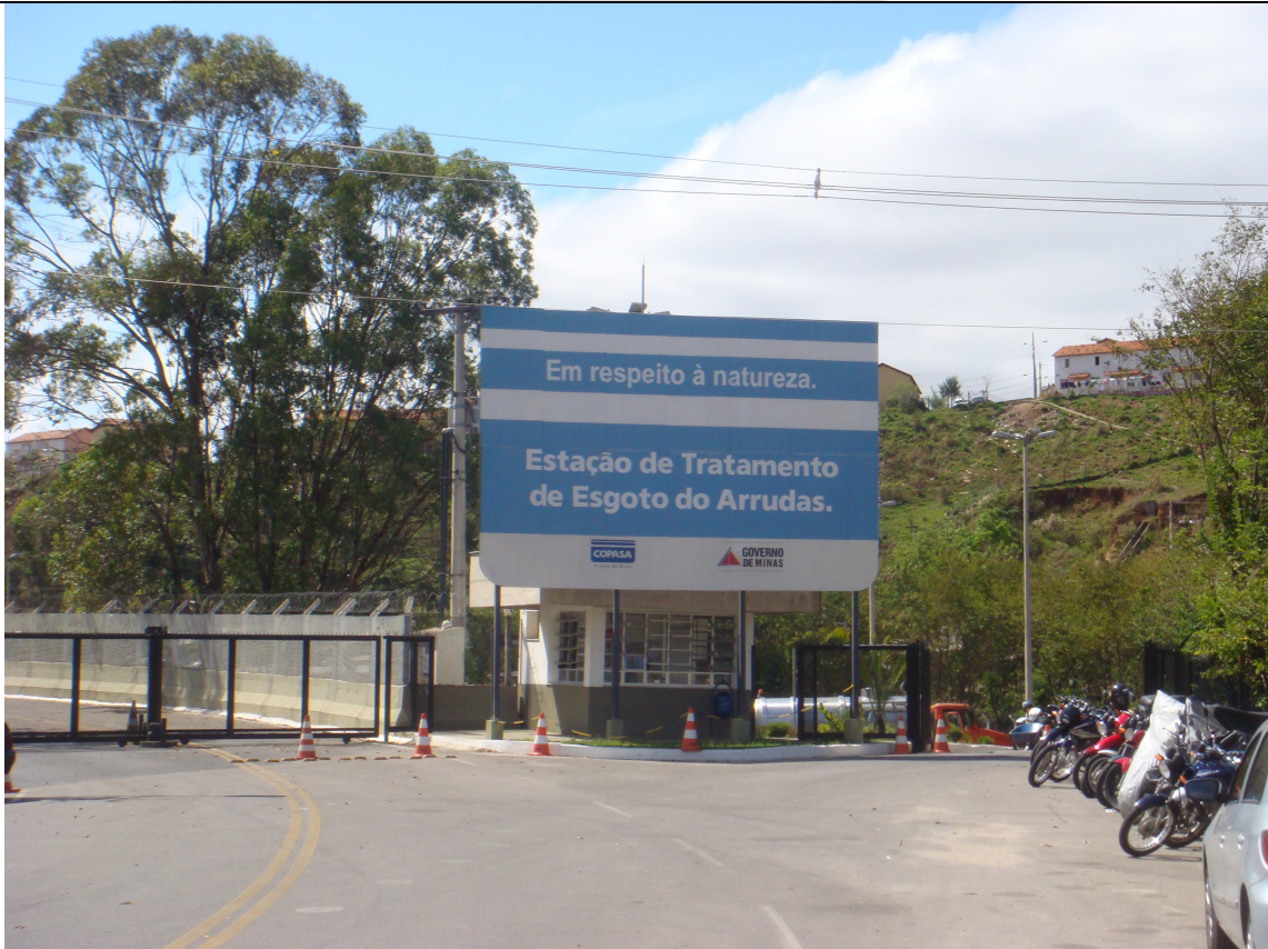
Foto 01: Placa de identificação da Estação de Tratamento e do empreendedor junto à guarita principal/portões de acesso
