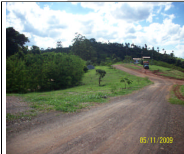
Foto 01: Vista geral do acesso ao Aterro Sanitário.
