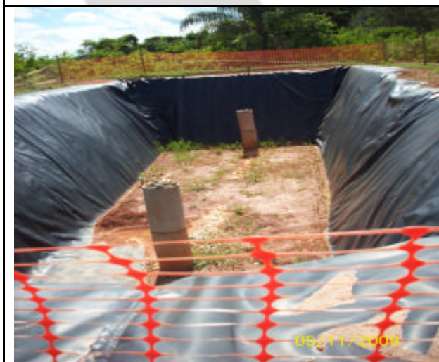
Foto 03: Nova vala a montante da atual.
