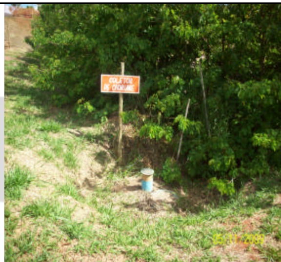
Foto 06: Poço coletor de chorume.
