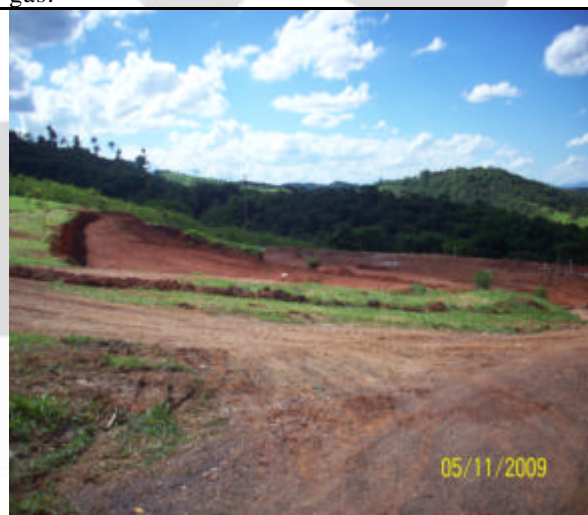
Foto 04: Abertura de nova vala, ao lado da atual.
