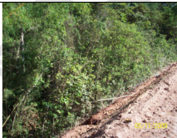
Foto 14: Área do antigo lixão recuperada.
