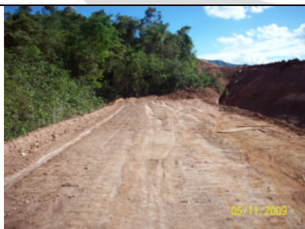
Foto 15: Área do antigo lixão recuperada.
