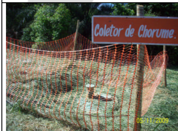
Foto 07: Poço coletor de chorume.
