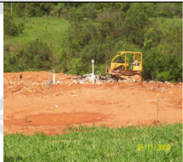
Foto 02: Vista geral da área em uso. Nota-se dreno de gás.
