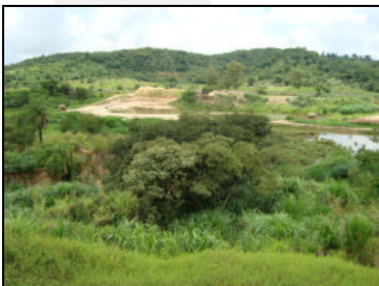
Foto 05. Vista do empreendimento a partir da margem esquerda (APP) do Ribeirão das Areias (Ponto oposto ao das fotos 03 e 04).
