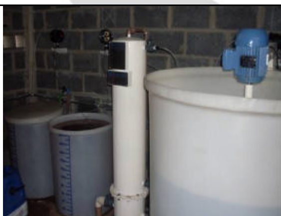
Unidade de apoio da ETE
