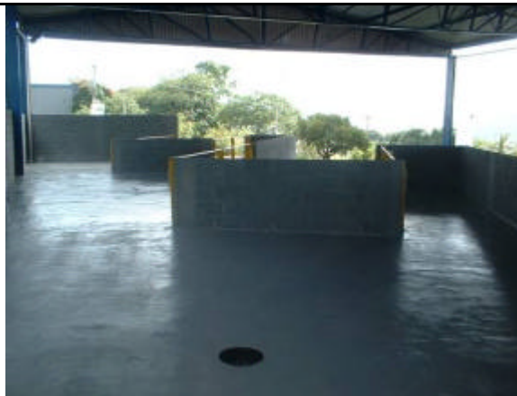
Piso do local de armazenamento de resíduos sólidos
