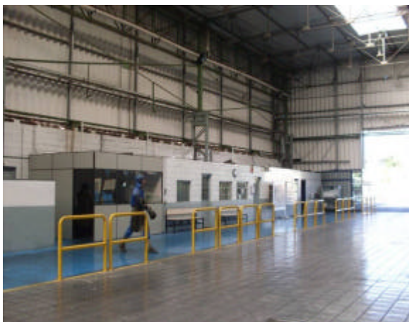
Piso do Galpão da Forjaria
