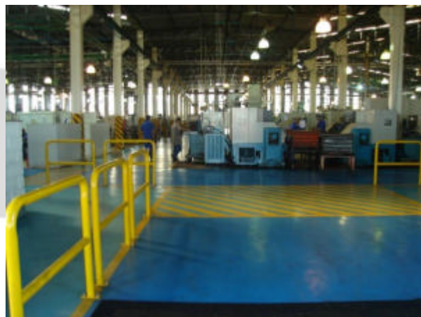
Piso do Galpão da Usinagem
