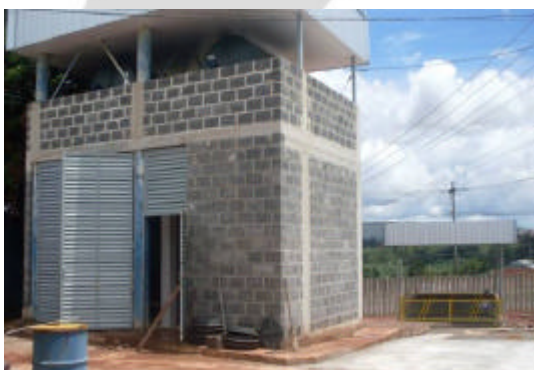
Unidade de apoio da ETE
