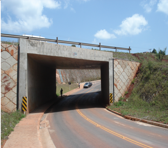
Foto 12 – Trincheira da BR 356 implantada pelo empreendimento
