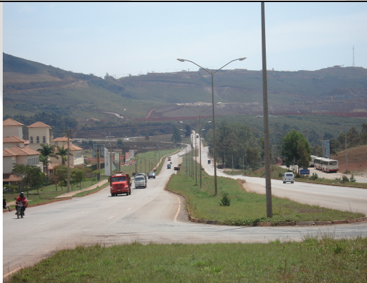
Foto 15 – Duplicação da BR 356 em frente ao empreendimento.
