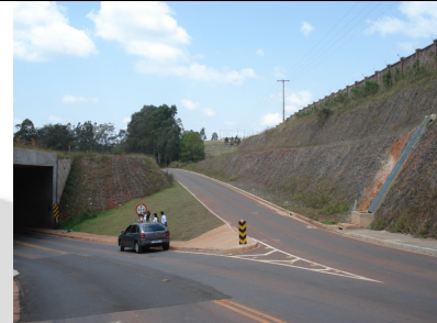
Foto 13 – Acesso à trincheira
