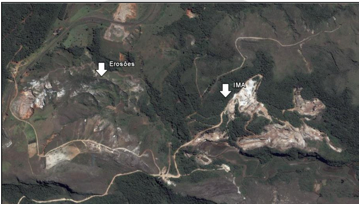
Imagem 02: vista das erosões (voçorocas) a montante do empreendimento da IMA, ambos com áreas aproximadas, que podem estar contribuindo para o assoreamento do curso d'água (Córrego da Usina). De acordo com essa imagem, há indícios de que o curso d'água a montante da IMA esteja bastante assoreado. (Fonte: Google Earth 2009).
