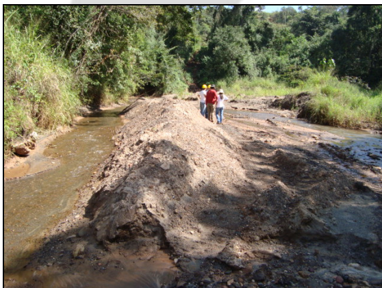
Foto 09. Assoreamento do Córrego da Usina e desvio (à direita do curso d'água) para captação de água.
