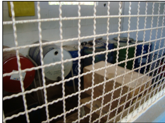
Foto 16. Estoque de combustível no galpão da oficina também necessitando de adequações.
