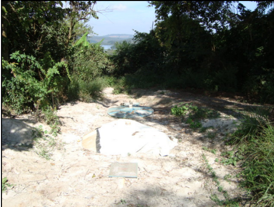
Foto 13. Sistema de efluentes sanitários próximo ao refeitório, alojamento e escritório.
