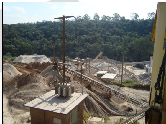
Foto 06. UTM vista do alimentador do britador primário (sump).
