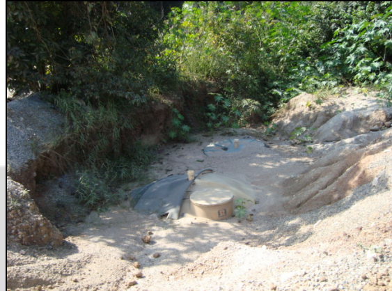
Foto 14. Sistema de efluentes sanitários próximo à oficina coberto com terra.
