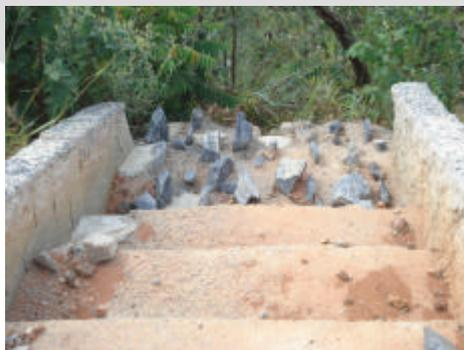
Foto 2: Dispositivo de dissipação de energia.
