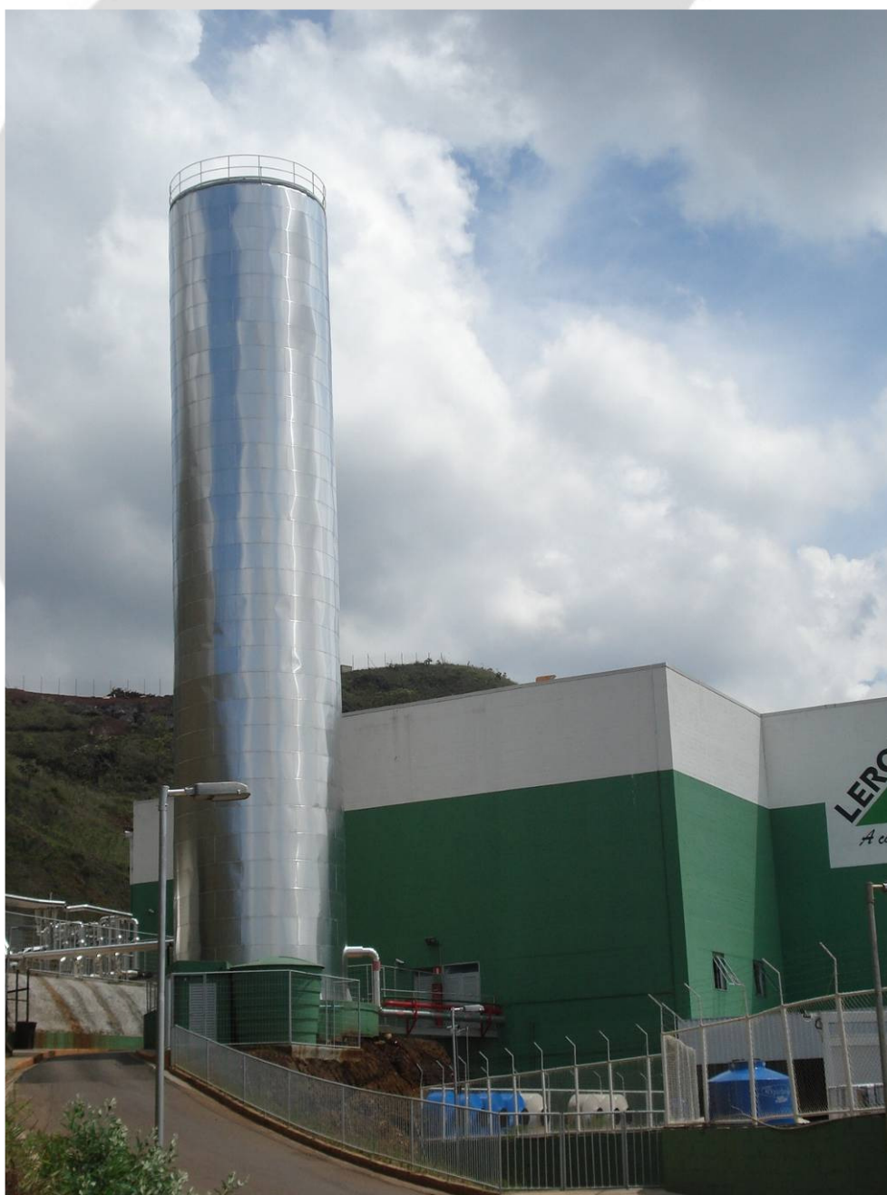
Foto 01: Reservatório circular de abastecimento de água (em primeiro plano)
