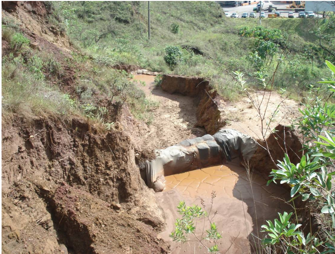
Foto 06: Estrutura de recuperação da área degradada
