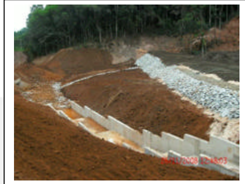
Ilustração 4: Canaleta Periférica Fonte: Relatório de atendimento de condicionantes
