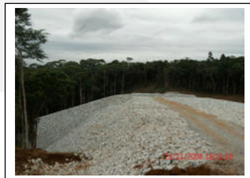
Ilustração 2: Dique de contenção de finos Fonte: Relatório de atendimento de condicionantes
