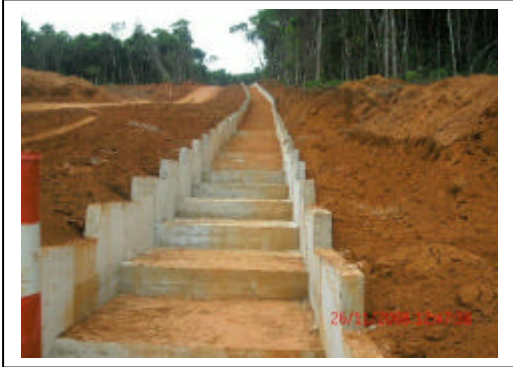
Ilustração 3: Canaleta Periférica Fonte: Relatório de atendimento de condicionantes
