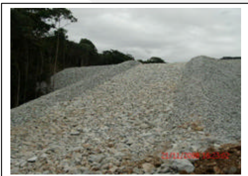
Ilustração 1: Dique de contenção de finos Fonte: Relatório de atendimento de condicionantes
