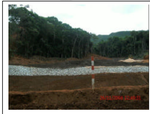
Ilustração 6: Dreno de fundo Fonte: Relatório de atendimento de condicionantes
