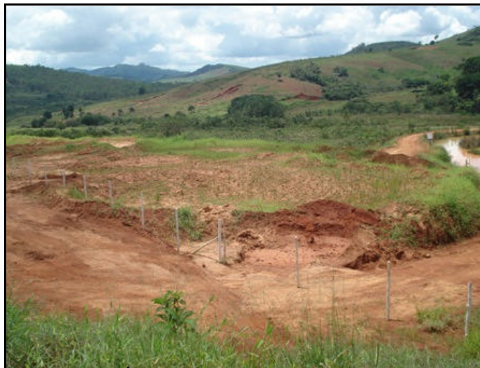
Foto 01: Área de depósito temporário de lama.
