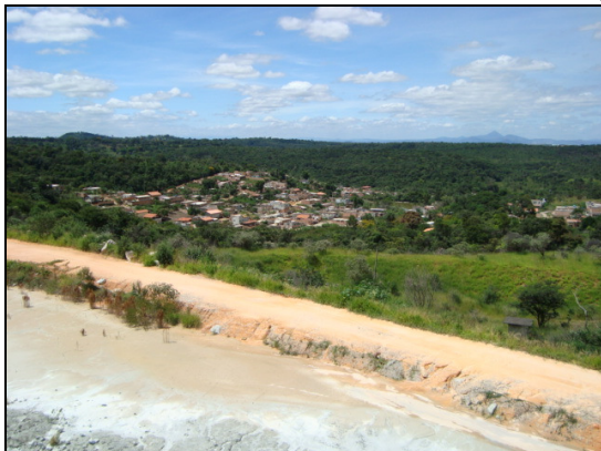
Foto 01. Detalhe das residências mais próximas à borda leste da cava e onde se pretende fazer o avanço da lavra (um dos dois sentidos).
