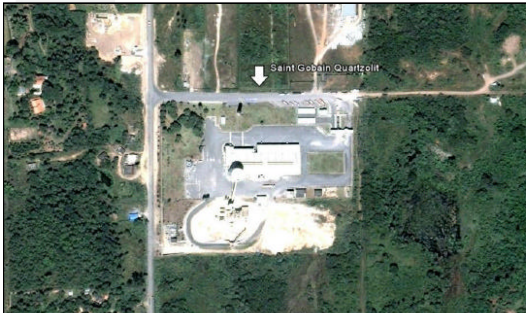
Imagem 02. Detalhe do empreendimento: unidade industrial de produção de argamassa (galpão) e unidade de secagem de areia (abaixo do galpão).
