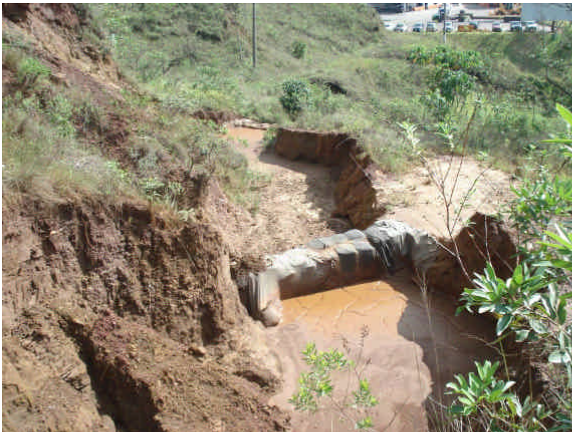
Foto 04: Estrutura de recuperação da área degradada
