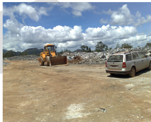
Foto 04: Máquina operando na pilha
