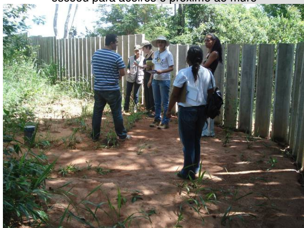
Foto 05: Aceiro próximo ao ponto de monitoramento de água subterrânea PMT04 com acúmulo de material carreado pela drenagem junto ao muro
