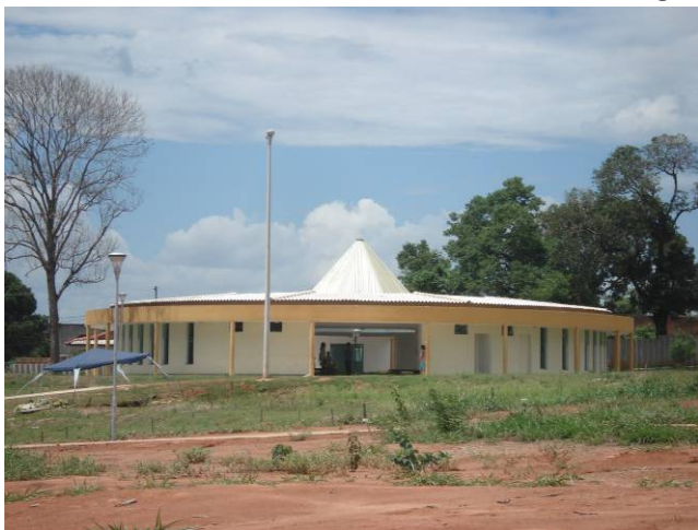
Foto 01: Área de velório, primeira área de sepultamento e trecho com solo exposto,
