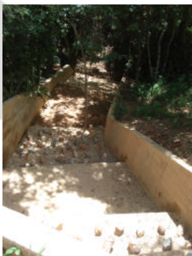
Foto 2: Dissipador de energia.
