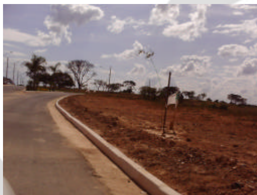
Foto 1: Pavimentação e arborização viária
