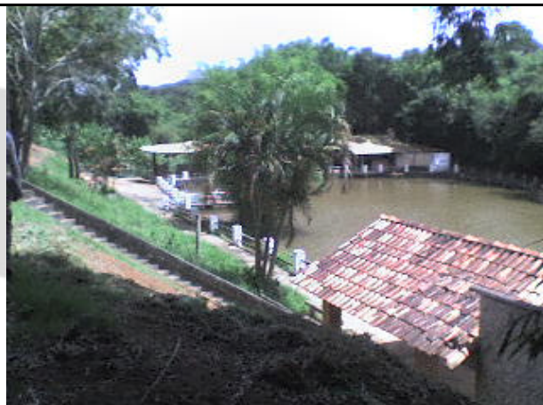
Foto 02: Barramento com vista de um das estruturas construtivas.
