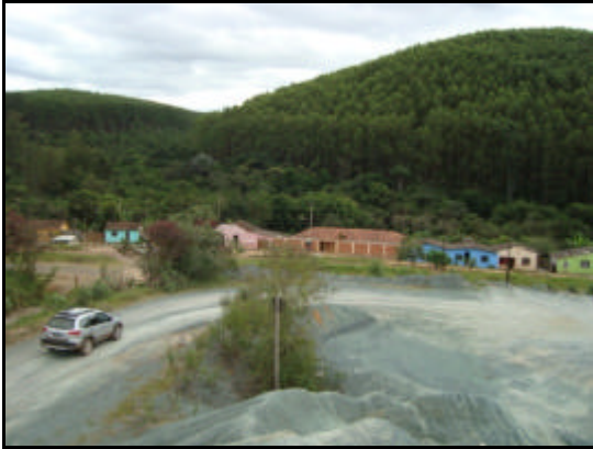
Foto 01. Vista do povoado de Costa Lacerda antes da pavimentação.
