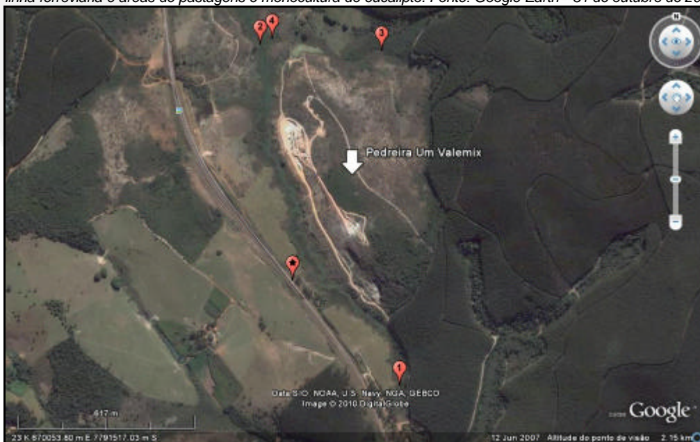
Imagem 03. Detalhe da imagem anterior: cava paralizada (ao sul), em atividade (ao centro); instalações a noroeste; cursos d'água e linha ferroviária ao oeste e norte, área de pastagem no entorno, monocultura de eucalipto na margem direita e pontos de monitoramento sismográfico (asterisco) na linha ferroviária e hidrico a montante (1 e 2) e a jusante do (3 e 4) do empreendimento.
