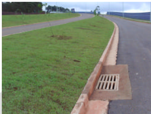
Foto 2: Boca de lobo e canaletas de drenagem .
