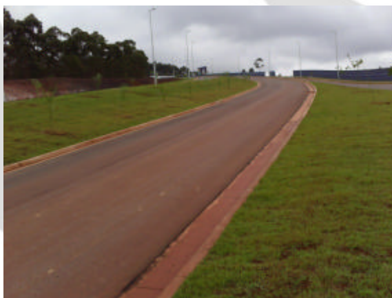
Foto 1: Pavimentação e arborização viária em frente a quadra M2B.
