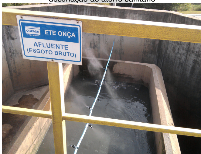
Foto 09: Aspersão de produto para redução de odores na entrada do tratamento preliminar
