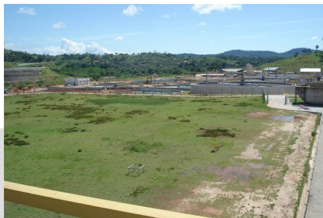
Foto 06: Área reservada para ampliação do tratamento primário, ao fundo tratamento secundário
