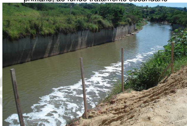
Foto 08: lançamento do efluente tratado no curso d'água
