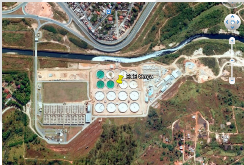
Figura 1 – ETE Onça – Fonte Google Earth, 2010
