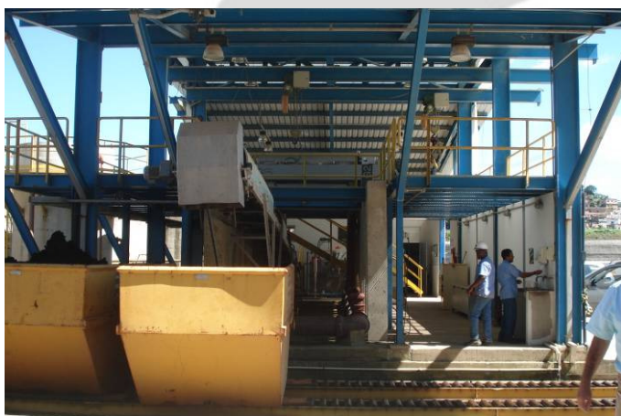
Foto 07: Lodo centrifugado nas caçambas para destinação ao aterro sanitário
