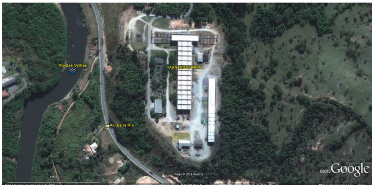
Figura 01- Vista aérea do empreendimento ASN Industrial Ltda
