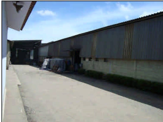
Foto 01. Via de acesso interna asfaltada e vista externa do galpão.
