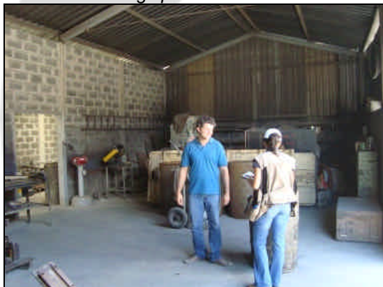
Foto 03. Oficina de pequenos reparos com piso impermeabilizado.
