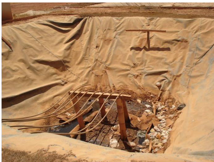
F11- Tratamento do chorume - lagoa anaeróbia set/2010
