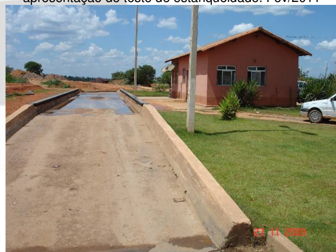
F16- Administração e balança para pesagem dos caminhões. Nov/2009
