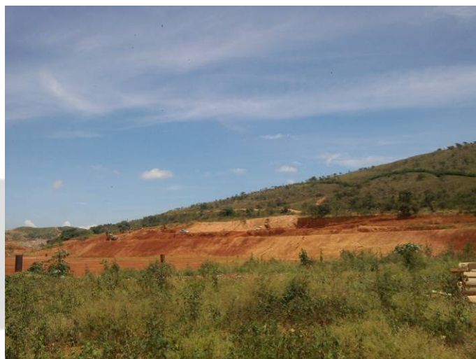
F6 - Primeira plataforma do aterro – ainda sem PEAD nos taludes e base apenas parcialmente implantada – fev 2011
