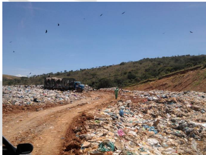
F4 - Resíduos sem cobertura no aterro controlado - atração de animais e presença de catadores. fev/2011
