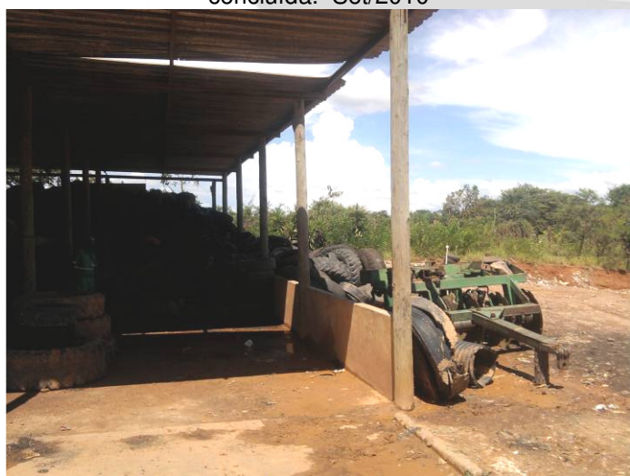
F15- Pátio de para recebimento e disposição temporária de pneumáticos – set/2010
