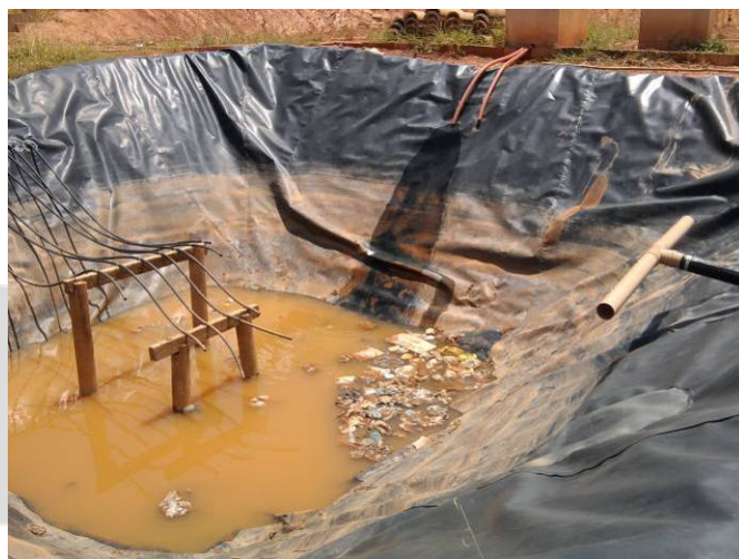
F12- Tratamento do chorume - lagoa anaeróbia fev/2011
