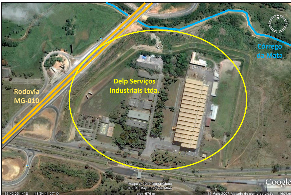
Figura 1. Visão geral do empreendimento, localizado no Distrito Industrial do município de Vespasiano. Fonte: Google Earth.
