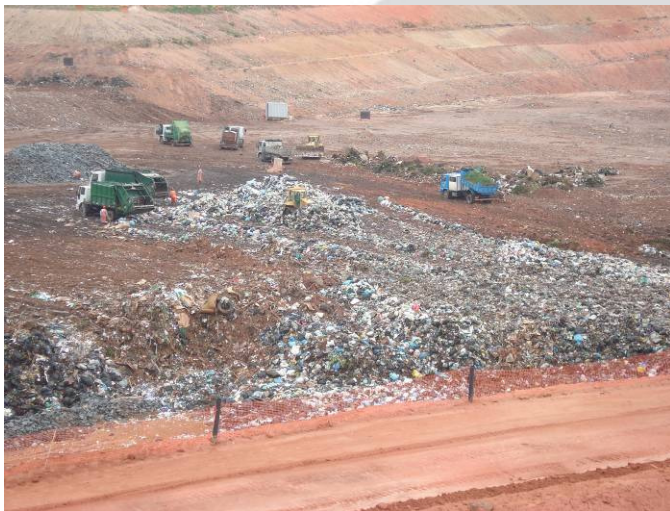
Foto1: Frente de aterramento de resíduos -2009
