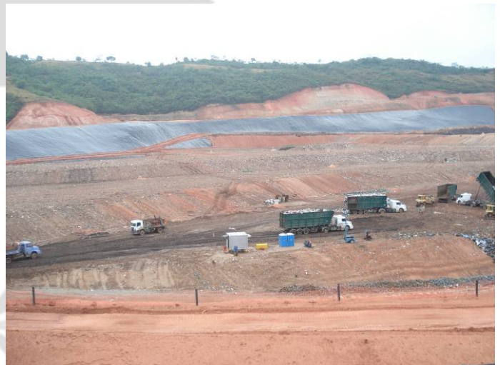
Foto2: Frente de aterramento de resíduos 2009
