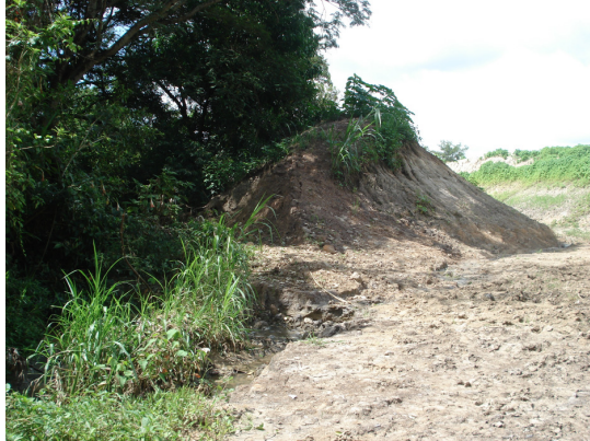
Foto 5: Leito original à esquerda e abertura da nova calha à direita – dez/2010
