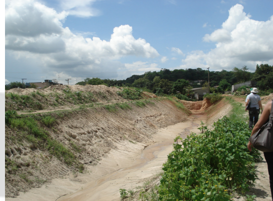
Foto 6: Abertura da nova calha – taludes aguardando revegetação e volume de terra disposto na margem – dez/2010
