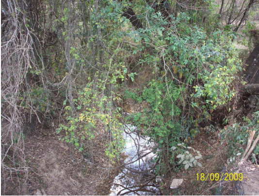
Foto 1: Córrego da Ponte Alta – calha a ser aterrada após a retificação do curso d'água – set/2009
