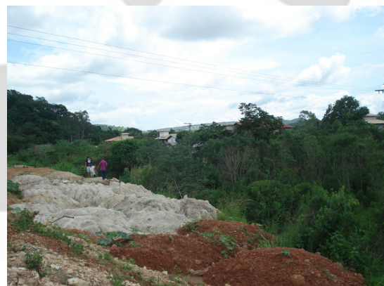
Foto 10: Volume de terra disposto na margem e APP do leito original – dez/2010
