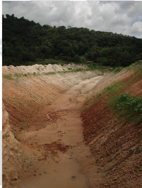
Foto 4: Abertura da nova calha – taludes aguardando revegetação e volume de terra disposto na margem – dez/2010
