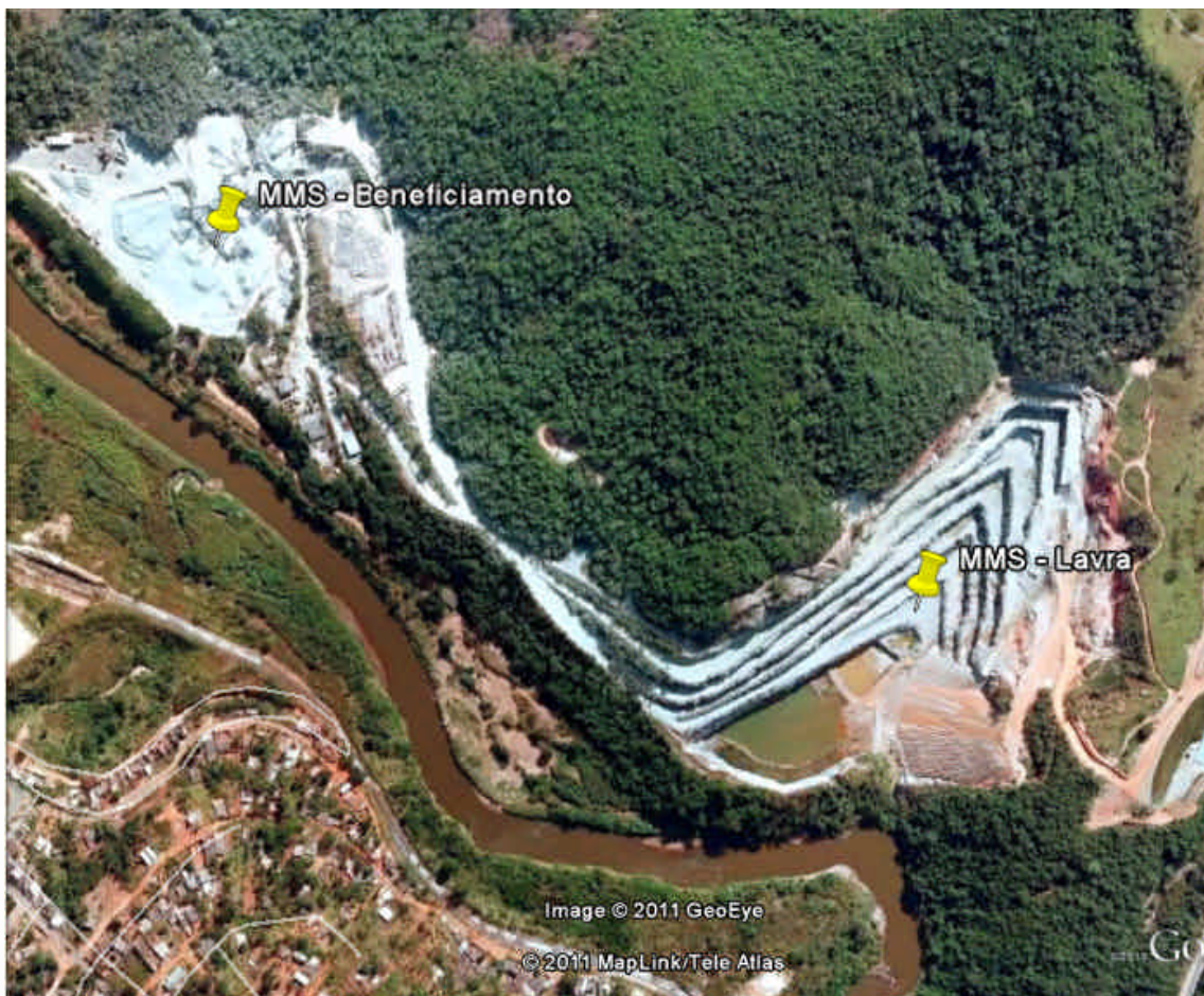
Imagem 01: vista da área do empreendimento Mineração Morro do Sino, com destaque para a área de lavra e beneficiamento.
