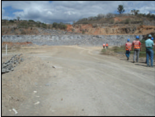
Foto 01. Vista da Mina III, em atividade.
