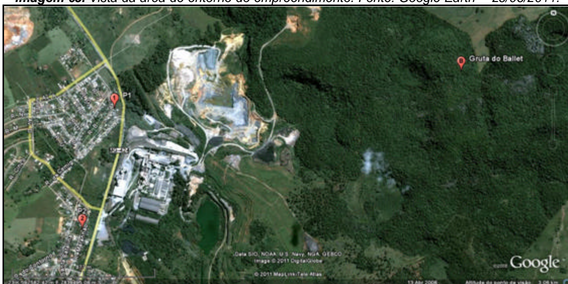
Imagem 06. Imagem anterior, demonstrando o complexo minerário da Lafarge (Cava e UTM), fábrica de cimentos e pontos de monitoramento sísmográficos P1 & P2 (comunidades vizinhas próximas) e B (Gruta do Ballet).
