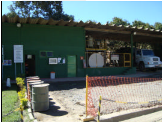
Foto 05. Tanque de abastecimento aéreo e oficina.
