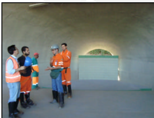
Foto 12. Centro de Apoio visto por dentro.
