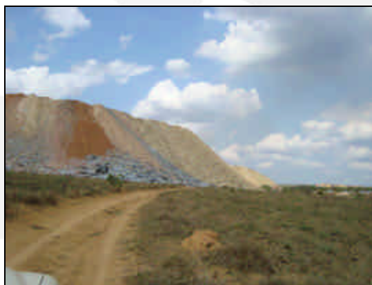
Foto 06. Vista do bota-fora que deverá ser envelopado para ser transformado em pilha-de-estéril.
