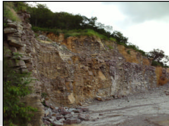
Foto 04. Frente de lavra paralisada, próxima à fenda "Fiote" do Urubu (extremidade leste).
