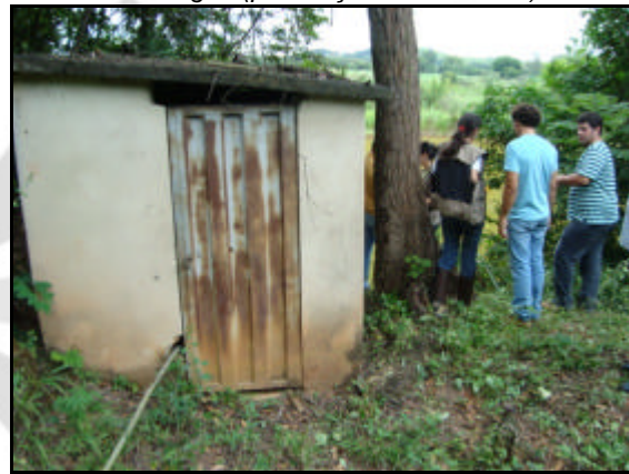
Foto 24. Propriedade vizinha – casa de bomba fechada.
