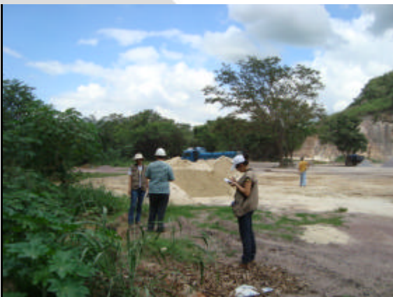
Foto 31. Local de aterramento de resíduos gerados no empreendimento.
