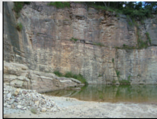
Foto 02. Talude com inclinação próxima a 90° e SUMP na cava.
