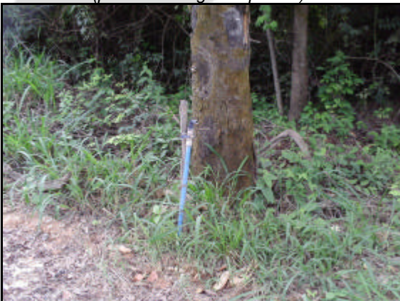
Foto 11. Sistema de aspersão nas vias de acesso.
